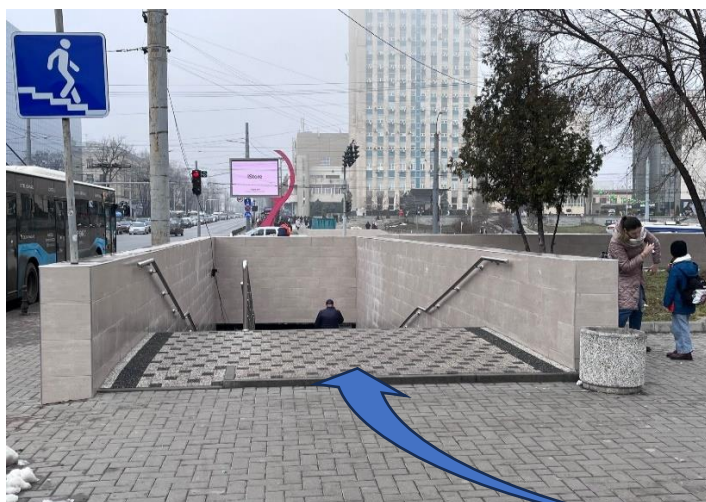
Imaginea 8. Treptele unice la intrare în subterană au înălțime mai mare de 6 cm și creează pericol de accidentare Sursa: foto CDPD
